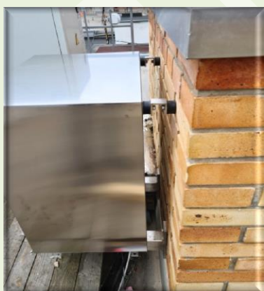
Akustický kryt, který nepřenáší vibrace do komínu a dále do domu.
